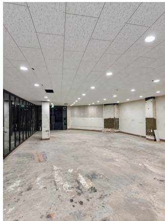
실내 조명 시공
