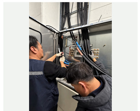
분전반 케이블 작업
